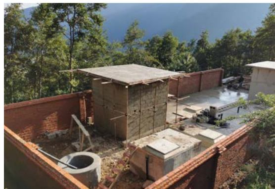
蓄水池工程主体建筑基本完工
