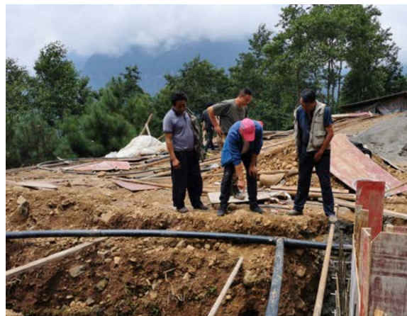
乡镇领导视察工程
