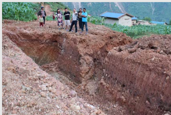
蓄水池主体挖掘完成
