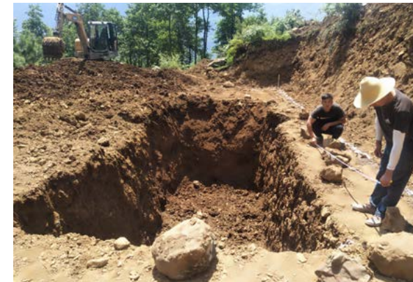
挖掘水池雏形 工作人员督导工程
