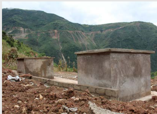
水池修建完工
