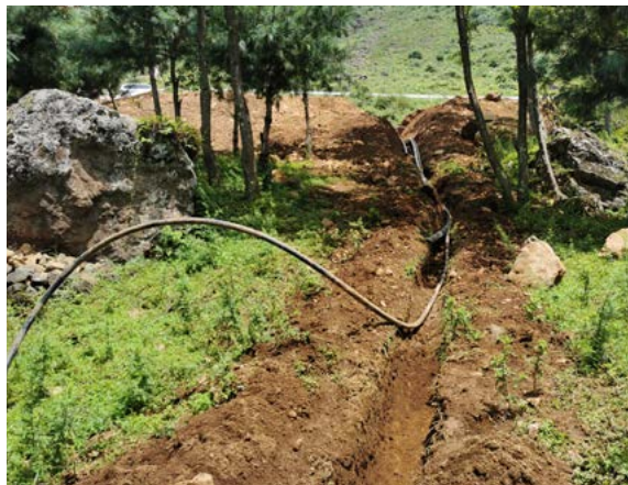
饮水管道铺设
