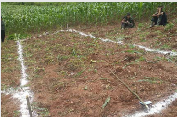
扎台村蓄水池开工
