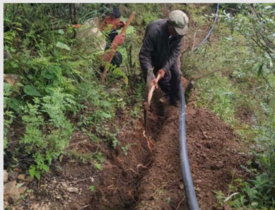
铺设水管道的沟渠
