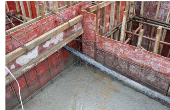
蓄水池主体结构浇灌水泥
