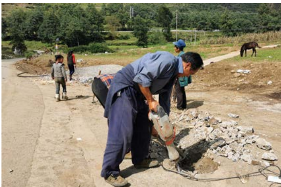
引水入村管道沟渠挖掘
